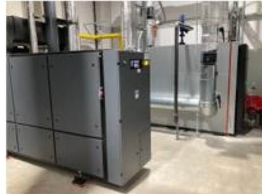
Blockheizkraftwerk
